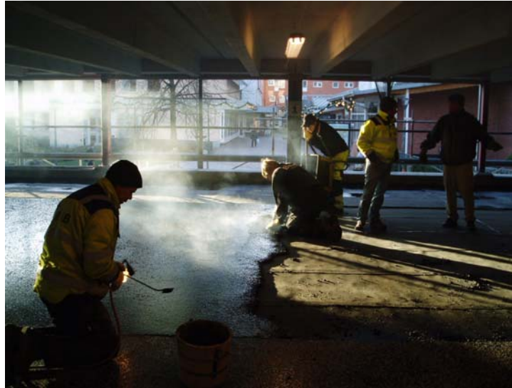
Rökutveckling vid läggning av PGJA utan vaxinblandning
